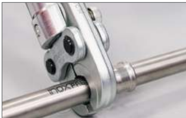
Assemblaggio attraverso pressatura / Making the press connection
