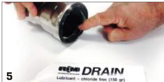
Lubrificazione zona interna guarnizione / Internal gasket lubrication
